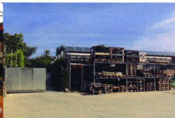
Foto 6: verharding en buitenopslag
