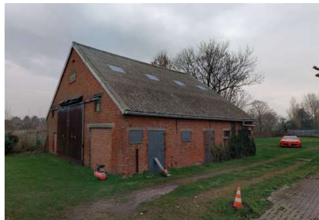
FIGUUR 26: Zoetenberm 23 (StreetSmart Cyclomedia, 26 november 2020)
