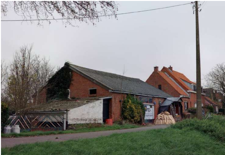
FIGUUR 8: De schuur (StreetSmart Cyclomedia, 26 november 2020)
