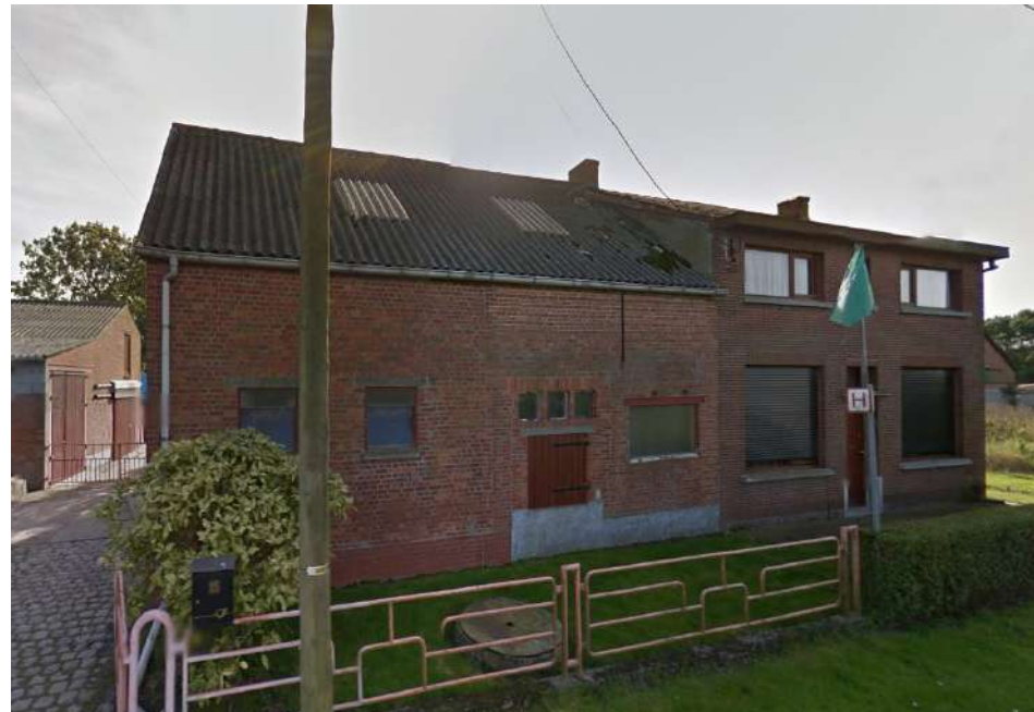
FIGUUR 6: Woning langs de Zoetenberm, benedendijks (bron: Google Streetview, oktober 2013)
