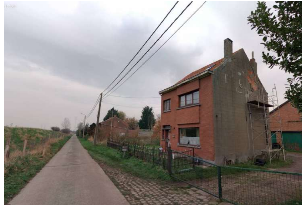
FIGUUR 6: Woning langs de Zoetenberm, benedendijks (bron: StreetSmart Cyclomedia, 26 november 2020)
