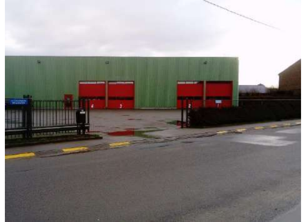
Ingang brandweerkazerne Kouterstraat
