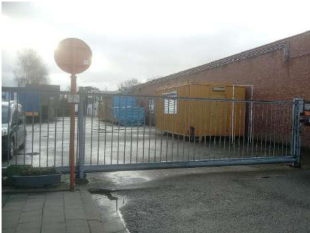
Toegang site gemeente aan de Kouterstraat
