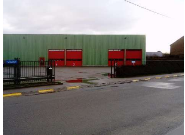
Ingang brandweerkazerne Kouterstraat
