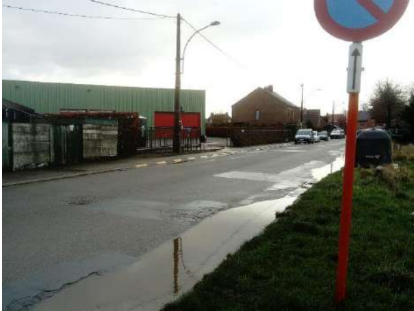
Ingang brandweerkazerne Kouterstraat
