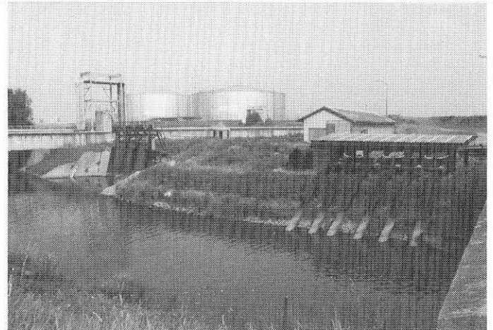
Noodinrichtingen ter hoogte van Betonsluis.
