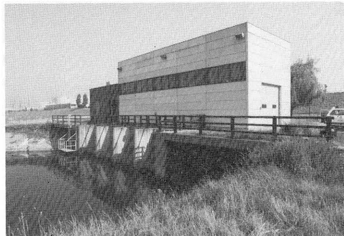
Pompgemaal « Vlaemschen Dijk » te Doel.
