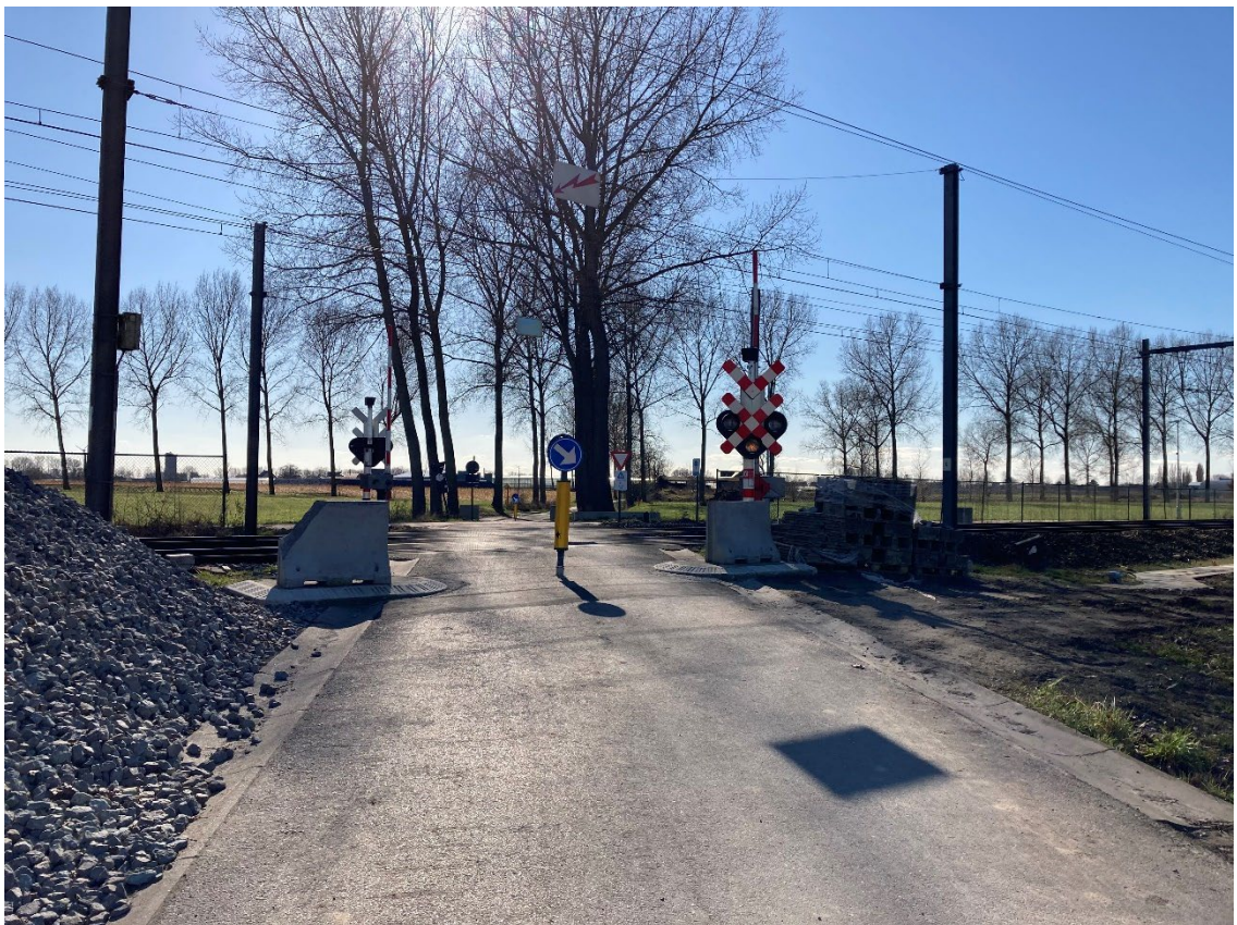
| foto 9: de spoorwegovergang van de Gentstraat
