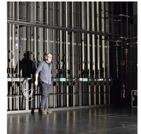
Ter Vesten krijgt nieuwe geautomatiseerde handtrekkenwand
