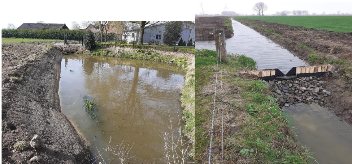
Figuur 6. Voorbeeld van (links) een bovengronds bufferbekken en (rechts) een gracht inclusief stuw in Beveren.
