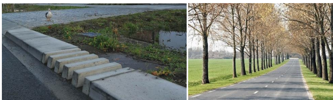
Figuur 19. De foto links is een voorbeeld van boordsteen met spletten zoals toegepast in de Fortstraat in Mortsel (Bron: dbpubiekeruimte.info ). De foto rechts toont de toepassing van bomen als verkeersremmer.
