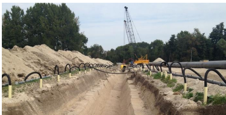
Figuur 8. Voorbeeld van een technische bemaling.
