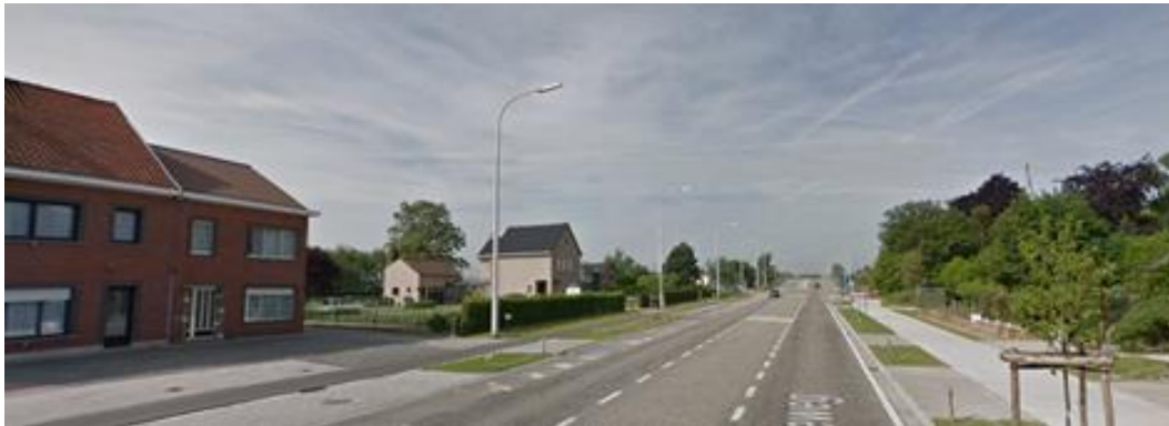
Foto 5: fietspaden N70 (bron: Google Maps)
