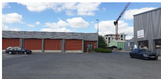
| Rechts: relatie Lidl en Waterfront, Stefdec Piping & Construction.
